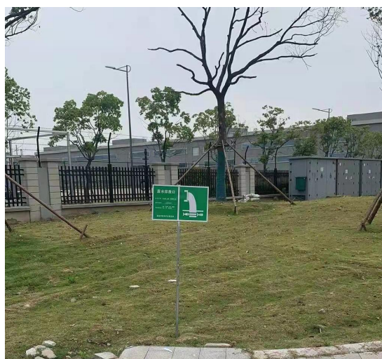
废水排放口标识牌
