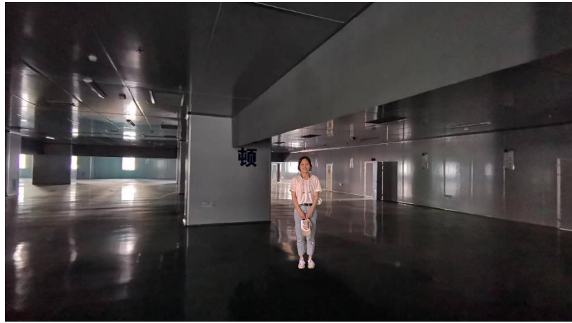
图 2-3 本项目所在 7# 厂房内部现场实物图
