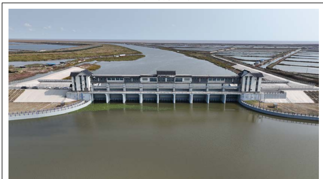
四卯酉闸（主体工程）
